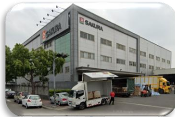
大雅二廠 - 熱水器、瓦斯爐
