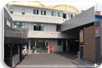
神岡廠 - 油煙機
